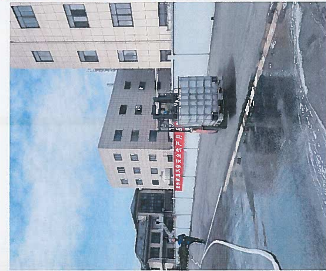
后期处置组组员徐信文驾驶叉车把吨桶放置与围堰旁，张军、方红云利用推车把收集泵、管路、电源线至围堰
